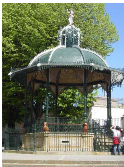
Figura 6 | Fotografia do Coreto de Canelas
